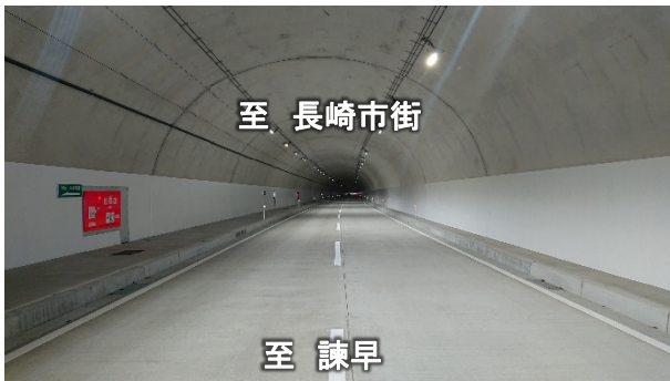
写真④トンネル坑内
