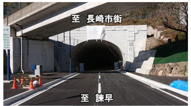
写真③トンネル坑口(芒塚側)
